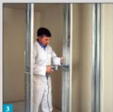
3 沿顶向龙骨方向每1.5m设一个可耐福安装龙骨。
