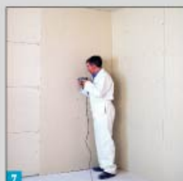
7 将可耐福石膏板安装在C型竖向龙骨上。
