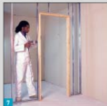
7 在C型竖向龙骨内嵌入木制线条以加固门框。
