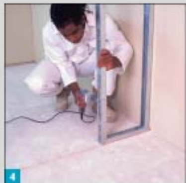
4 用U型沿地龙骨翼缘剪开并向上弯折以加固门框。
