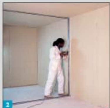
2 安装可耐福U型沿顶、沿地龙骨以形成隔墙框架。
