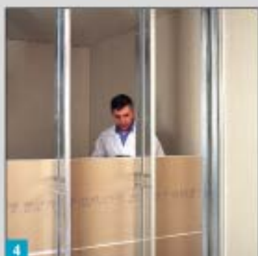
4 将可耐福厚板水平向安装在C型竖向龙骨上。
