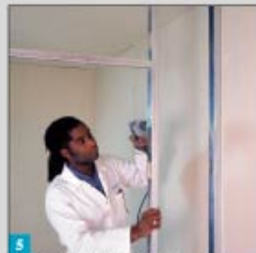
5 将U型龙骨剪开并向下弯折以形成门框。
