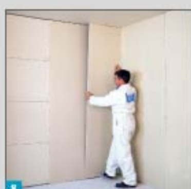
8 石膏板错缝安装, 以保证所有接缝错开。
