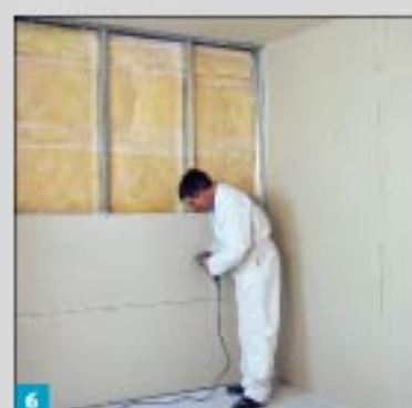
6 将另一侧的可耐福厚板水平向安装在C型竖向龙骨上。
